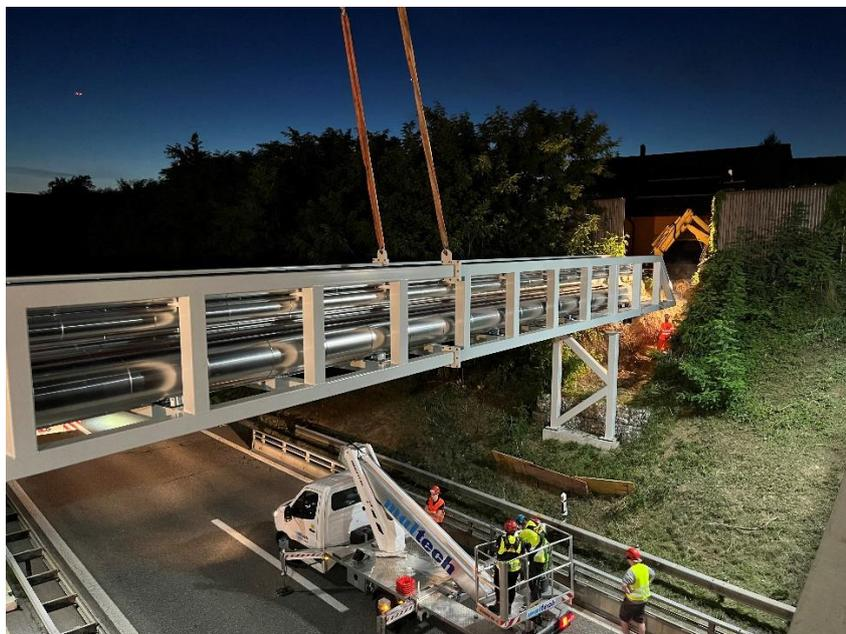
Nachteinsatz beim Versetzen der Rohrbrücke im Bereich Querung Autobahn N1
